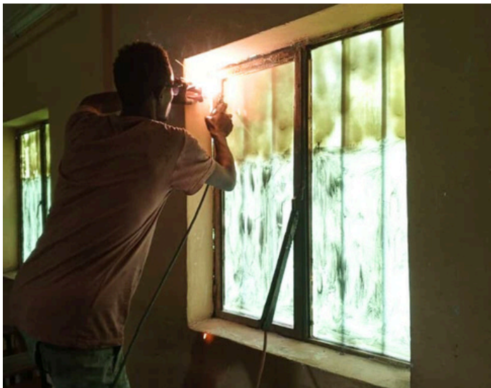
Fenster und Türen mussten repariert werden.
