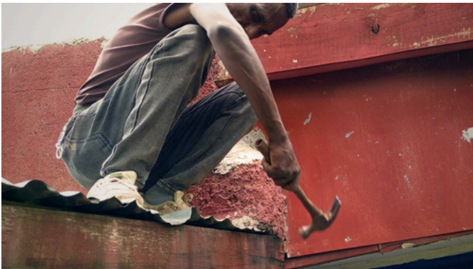
Reparaturen am Schulgebäude
